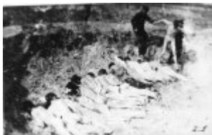
Exécution de masse dans le camp de concentration de Stutthof. (AIPN)
